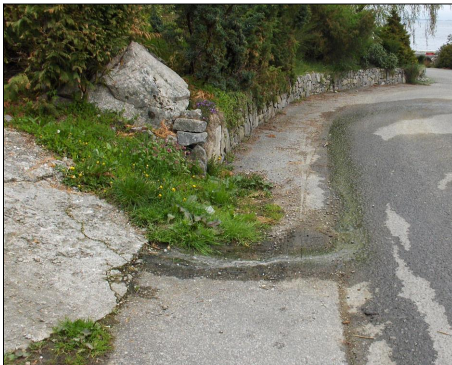
Uheldig utslipp fra defekt renselagg
