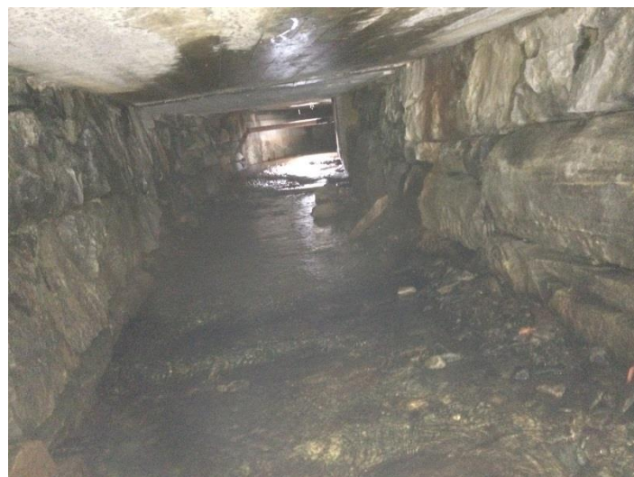
Nitterelva, kulvert under fylkesvegen.
