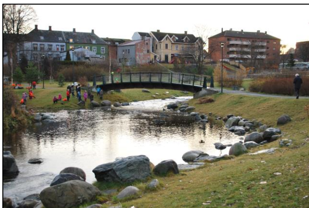
Bilde 3. Ilabekken i Trondheim ble gjenåpnet i 2006 etter å ha ligget flere tiår i rør under et industriområde. Som del av gjenåpningen ble det etablert terskler, lagt ut gytegrus og større steiner, og etablert kulper. Gjenåpningen har hatt stor betydning for bymiljø og lokalt friluftsliv. Ørreten var tilbake allerede i 2007. Foto: Line Fjellvær.
