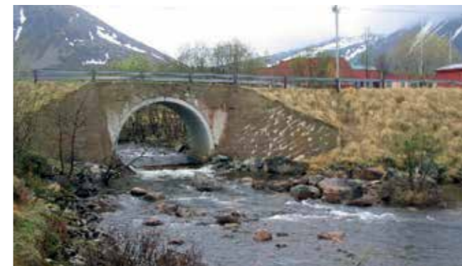
Kulverten i Storelva før utbedringen. Sterk strøm gjennom kulverten, grunn kulp og fall ved utløpet vanskeliggjør fiskevandring. (Foto: Knut Aune Hoseth, NVE Region nord).
