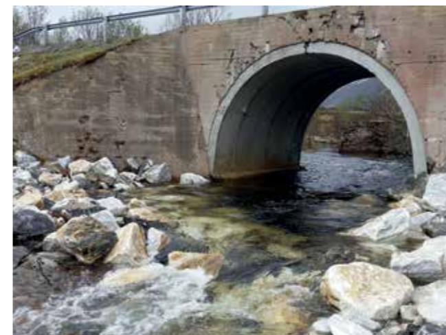
Terskel anlagt nedstrøms kulverten. Vannspeilet er hevet og står nå inn i kulverten. (Foto: Øyvind Haugland, Statens vegvesen Region nord).
