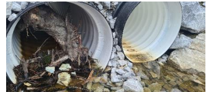
Bekk lagt i rør. Foto: Kristin B. Klausen
