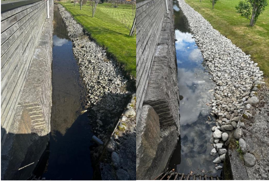
Figur 7: Tiltaksgjennomføring før og etter fjerning av finsediment og pukk. Foto: Trine S. Røyneberg.
