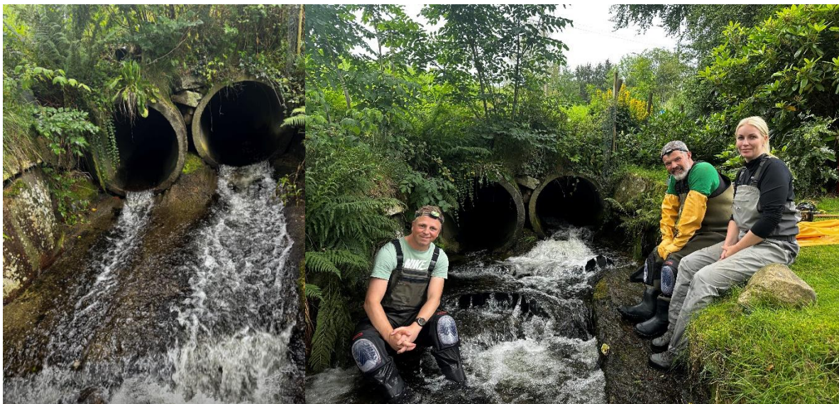
Figur 12: Før og etterbilde av montering av fleksiterskler i og utenfor kulvert i Litlå i Bjerkreimsvassdraget. Foto: Trine S. Røyneberg.
