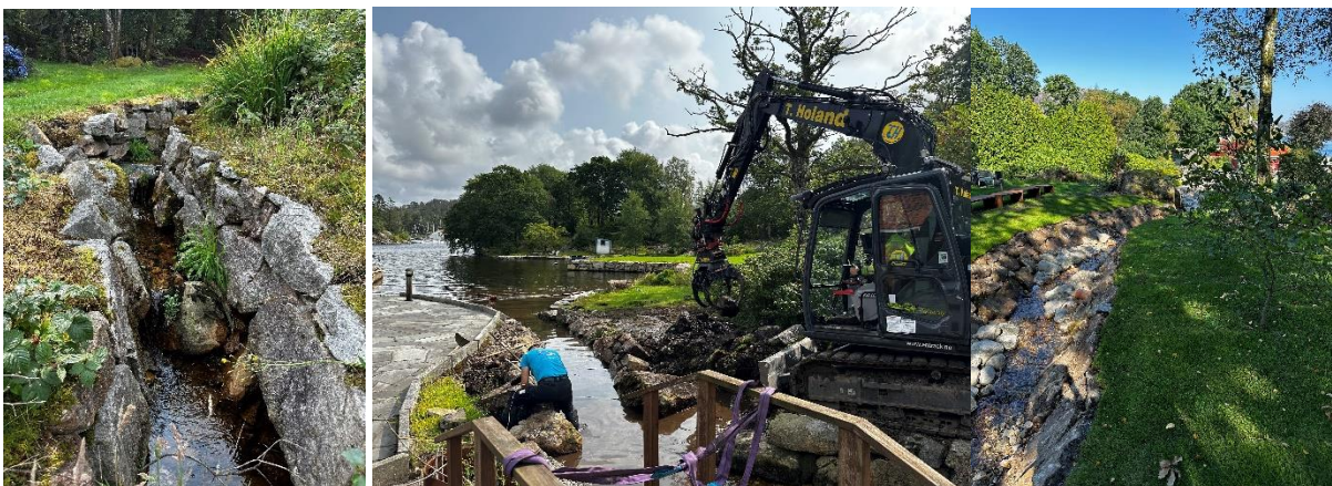
Figur 20: Til høyre; Bekkeløpet før tiltaket. Til venstre; Bekkeløpet etter utbedring, nå med økt kapasitet. Foto: Trine S. Røyneberg.
