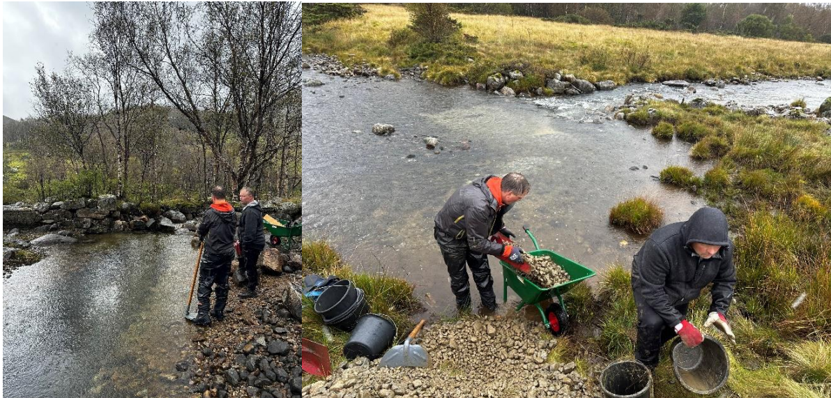
Figur 9: Utlegg av gytegrus ved utosen av Hegelstad tjørna i Bjerkreimsvassdraget. Foto: Trine S. Røyneberg.
