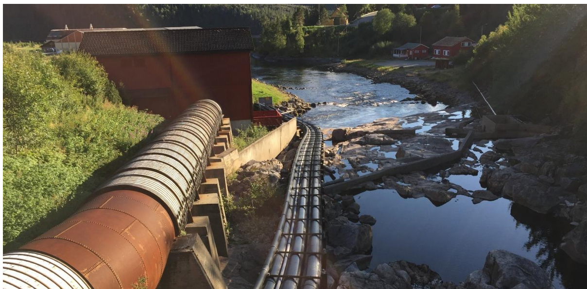
Bilde 4: Oppløyvelva, Ytre Namdal vannområde. ©Bendik Eithun Halgunset.
