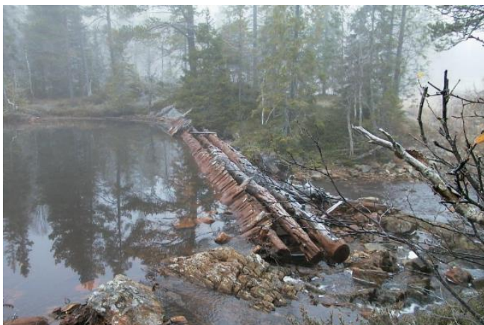
Bilde 5: Ved utløpet av Malisætertjønnna hindrer en demning fra 1700-tallet, opprinnelig oppsatt ifm. sagbruksdrift, at store mengder foruensa gruvemasser fra Dragset Verk (1869 – 1909) blir ført ut i Ringavatnet og Hostovatnet som i dag er populære fiskevann. Foto: Odd Lykkja.
