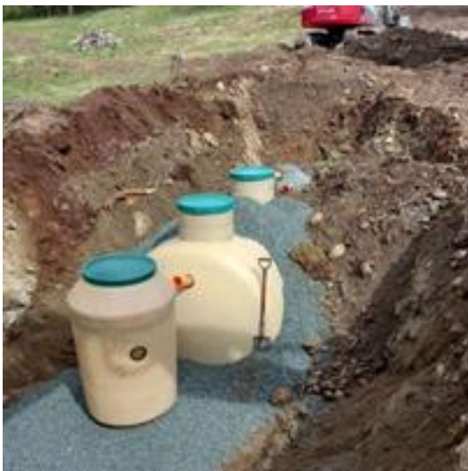
Bilde 2: Nytt avløpsanlegg under etablering. Foto: Bente Solem, Orkland kommune
