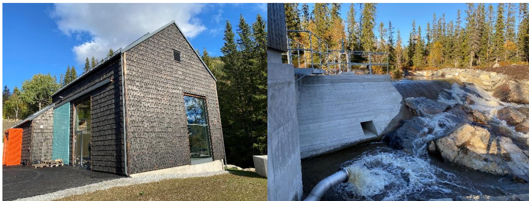
Figur 1 Gjuvåa kraftverk i Tuddal. Kraftverket ble ferdigstilt september 2021. Bildet til høyre viser inntaksdammen. Foto: Ellen Esborg
