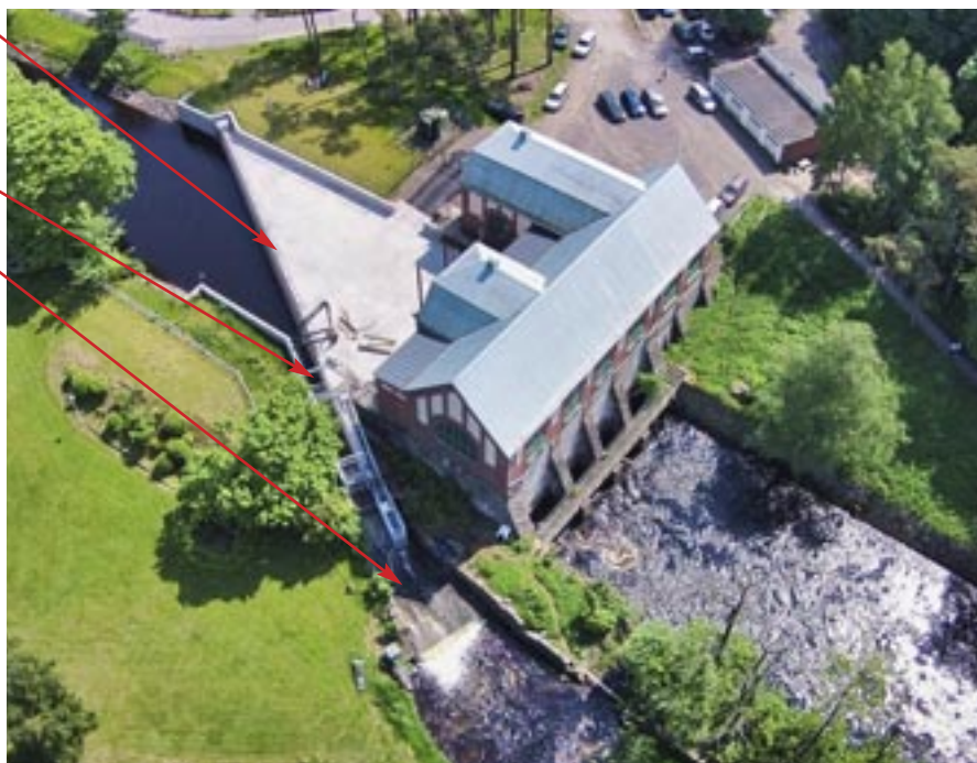
Fig. 46 Vannkraftverk Herting i Ætran med beta-varegrind foran inntak, fluktåpning og omløp. Løsningen har meget gode resultater for nedvandring av blankål (95 %), laksestøinger (96 %) og laksesmolt (91–98 %, Foto: Fiskevårdsteknik AB, Sverige, med tillatelse, Calles m.fl. 2015, Nyquist m.fl. 2017).
