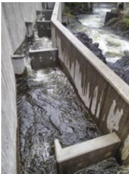
Fig. 38 Norges første spaltetrapp i Akerselva Oslo med typisk diagonalt strømningsmønster, gjennomgående bunnsubstrat og nålestengsel ved inntaket til finregulering av vannføring (Oslo kommune, NORCE LFI, Norconsult, 2014).
