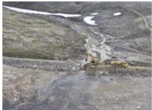
Fig. 156 Sommeren 2019 ble deler av demningen ved utløpet av Einøvlingsvatnet fjernet og vannstanden i innsjøen ble senket med ca. 1 m. Dette var nyttig for å vurdere behovet for fysiske tiltak i utløpsosen, på elvestrekningen mellom det nye/opprinnelige utløpsoset og demning, og på elvestrekningen nedstrøms I 2020 ble hele demningen fjernet. Vannstanden på bildet representerer det man antar er naturtilstanden (foto: Forsvarsbygg (venstre) og Dagmar Hagen (høyre)).
