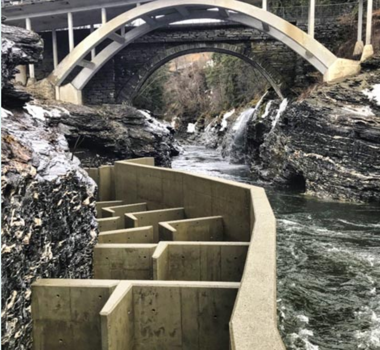
Spaltetrappen under bygging med juvet bak
