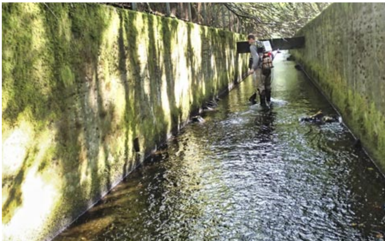
Fig. 67 Det er lite fisk på elvestrekninger som har blitt erosjonssikret med plastring eller betong fra alle kanter. Slike lokaliteter mangler skjul, variasjon, gytegrus og tilgang til hulrom i elvebunnen. Strømhastigheten er stor ved flom, og tilførselen av gytegrus og rullestein fra elvebredden er blokkert.
