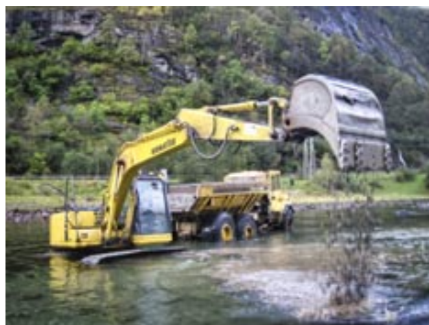
Fig. 136 Ripping (venstre) og utlegging av gytegrus (høyre)
