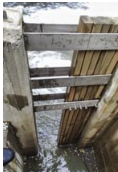
Fig. 38 Norges første spaltetrapp i Akerselva Oslo med typisk diagonalt strømningsmønster, gjennomgående bunnsubstrat og nålestengsel ved inntaket til finregulering av vannføring (Oslo kommune, NORCE LFI, Norconsult, 2014).
