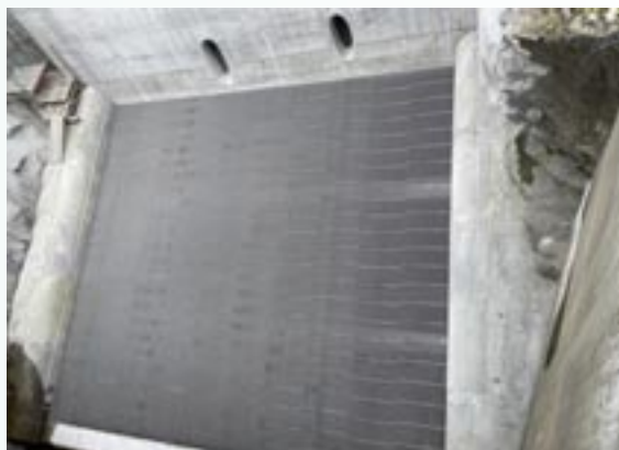
Alfa grid 15 mm med bypassinntak
