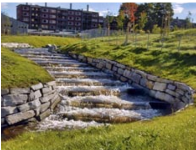
Fig. 113 Ilabekken etter gjenåpning med etablering av fisketerskler og gyteområder for sjøørret.
