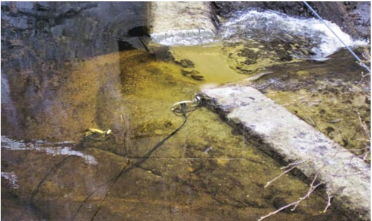
Flukttåpninger er et viktig hjelpemiddel for å få nedvandrende fisk trygt forbi demninger og kraftverk. Her fra demning Tveitofoss kraftverk i Bjoreio, Hordaland.
