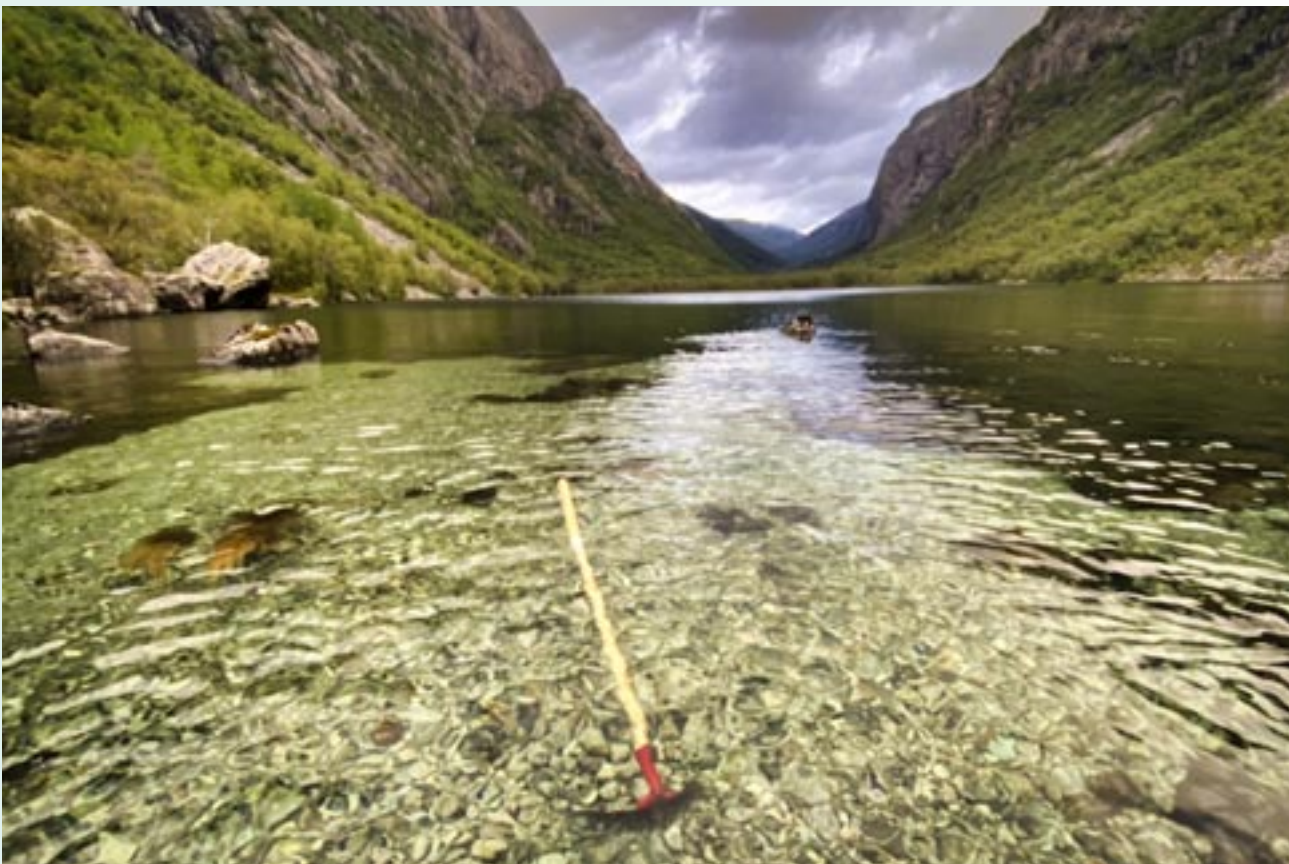
Gytegrusutlegg med helikopter på utoas av Røssdalsvannet i Espedalselva September 2021. Totalt 128 tonn gytegrus ble lagt ut med Helitrans. (Foto: Knut Ståle Eriksen)
