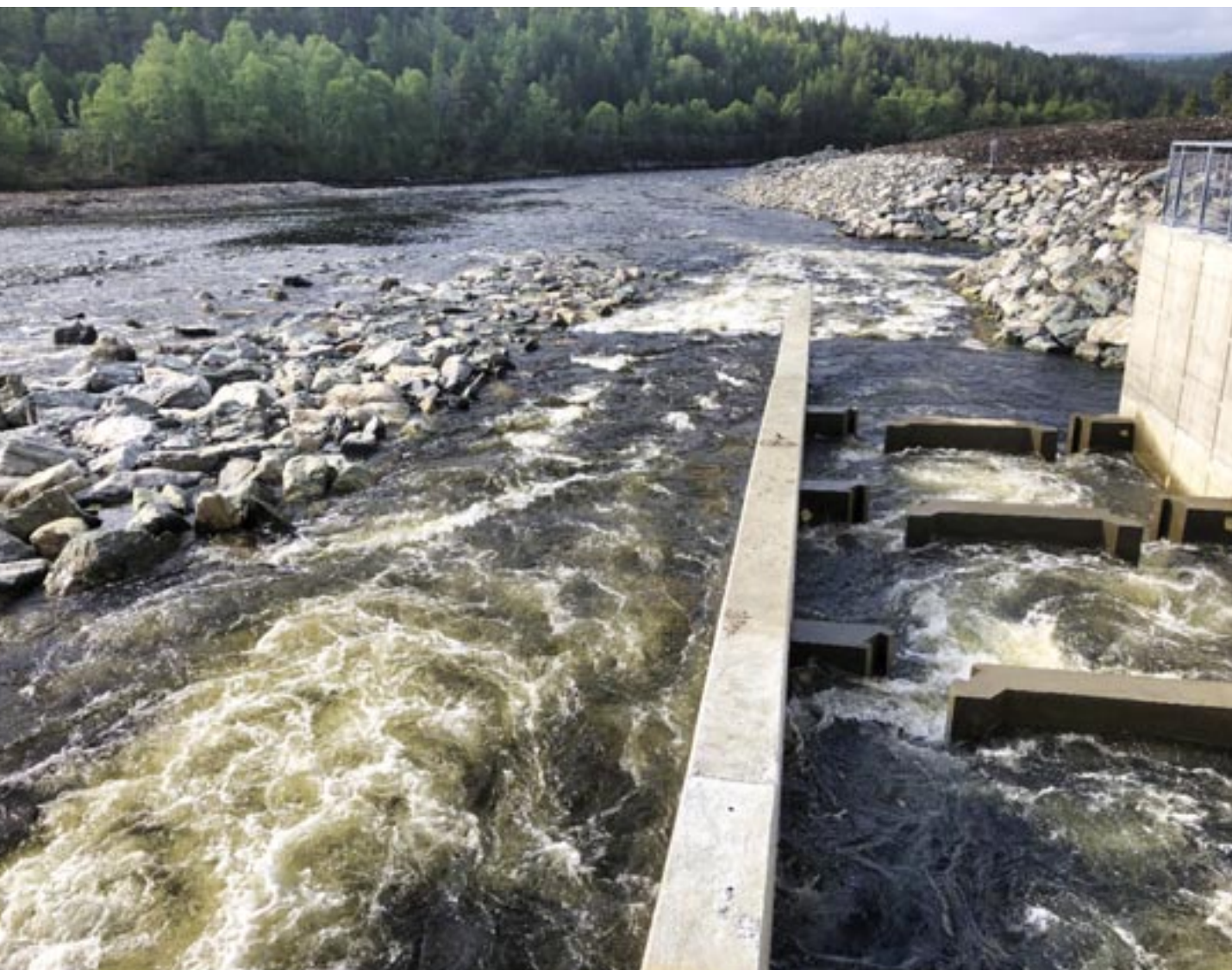
Fig. 40 Fiskepassasje forbi Tolga kraftverk. Kombinasjon av dobbeltspaltetrapp (5 m 3 /s) og rampe ved lav vannføring (3 m 3 /s), og over hele terskelbredde ved høy vannføring gir fisken forskjellige muligheter for oppvandring, noe som kan være nødvendig i vassdrag med høy artsdiversitet. Regulant: Hafslund Eco/Opplandskraft, Prosjekterende: Norconsult i samarbeid med NINA Lillehammer. (Foto: Norconsult)
