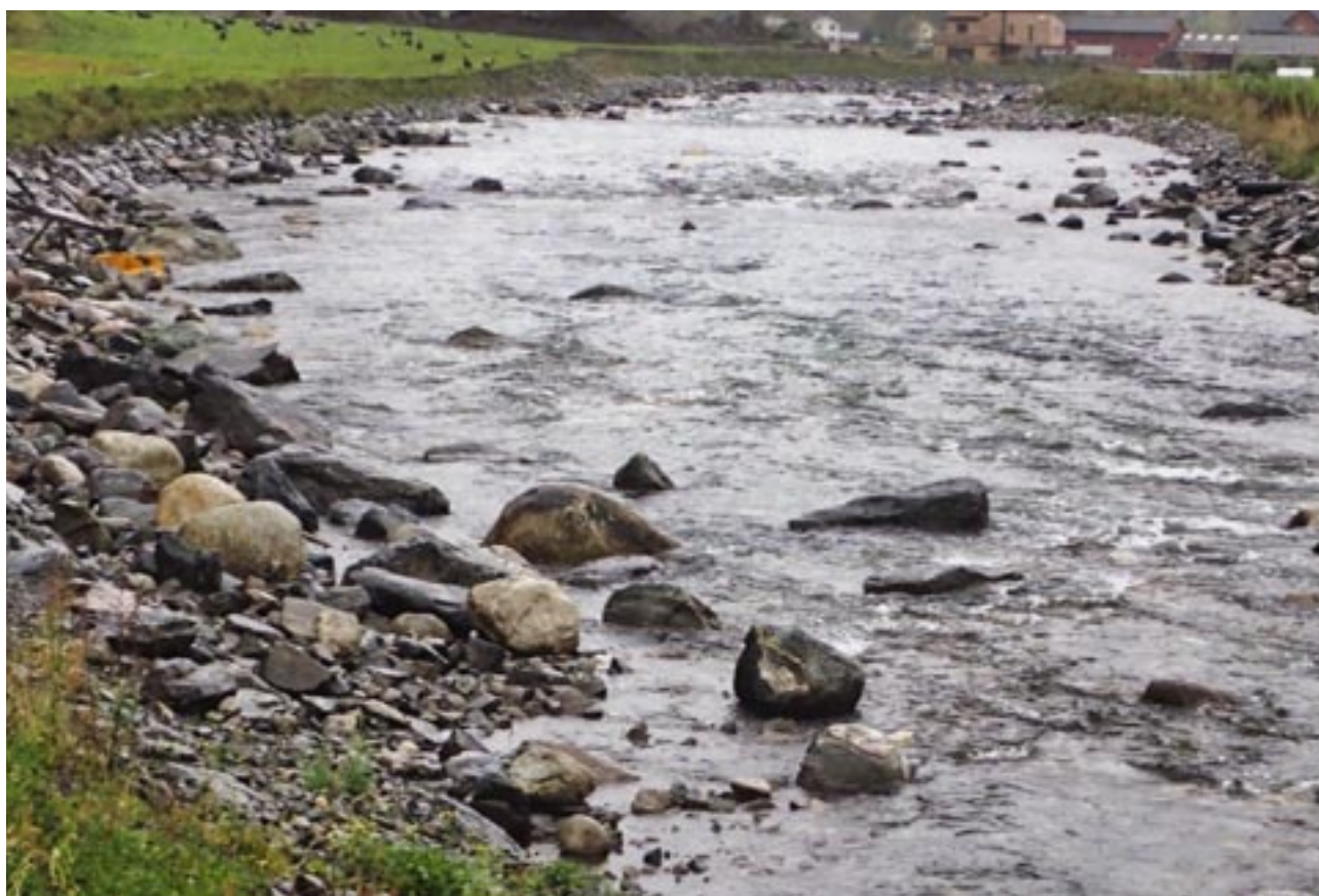
Tradisjonell erosjonssikring med glatt plastring (øvre bilde) og tilbaketrukket erosjonssikring med mer naturtypiske elvebredder (nedre bilde Flåm 2017, NVE med NORCE LFI).
