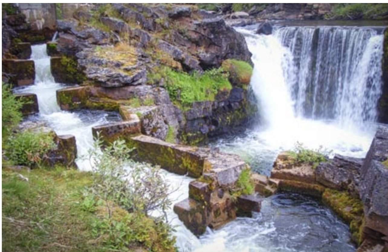
Fig. 41 Klassisk kulpetrapp for laks i Bergebyelva, Finnmark. (Foto: Hans-Petter Fjeldstad)
