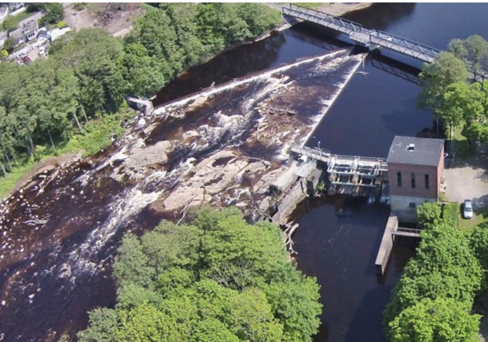
Naturtypisk omløp ved Herting kraftverk i Ätran (Sverige, se også nærmere beskrivelse i kap. 9). Omløpet har minst 11 m 3 /s og brukes både til opp og nedvandring av fisk. (Foto: Fiskevårdsteknik AB)
