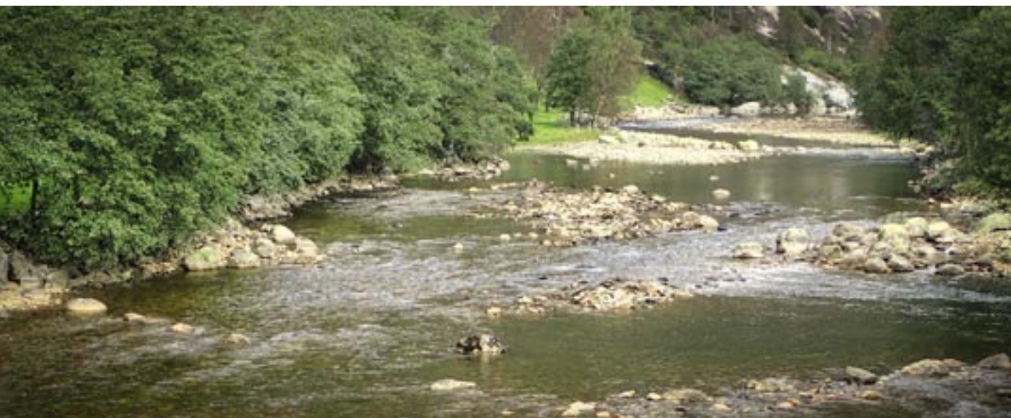
Buner bygget opp av enkeltstein etter naturtypiske forbilder. Buner bidrar til konsentrering av vannstrøm ved lave og mellomstore vannføringer, og de gir økt morfologisk variasjon. Buner brukes også for å konsentrere vannføring ved elv i elv-prinsippet (s. 79). Bildet er fra Frafjordelva 2016.
