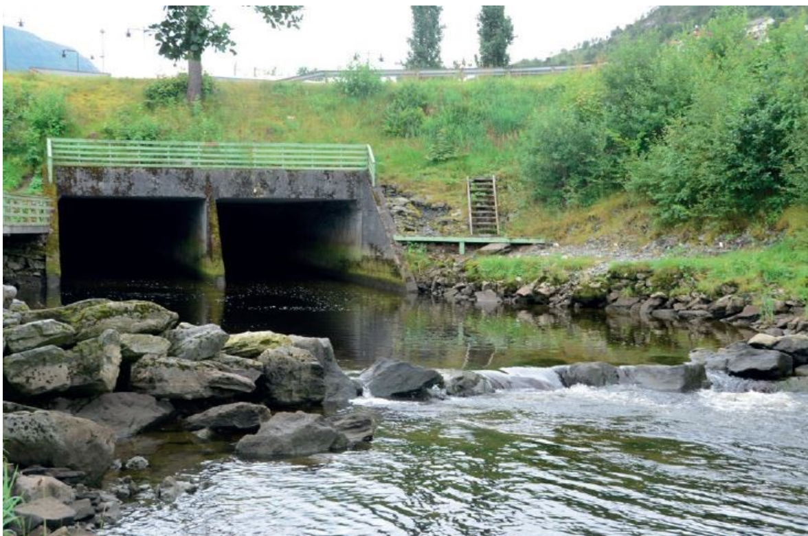
Bilete 7. Kulvert ved Arna jernbanestasjon med innløpskulp. Foto: Sveinung Klyve.
