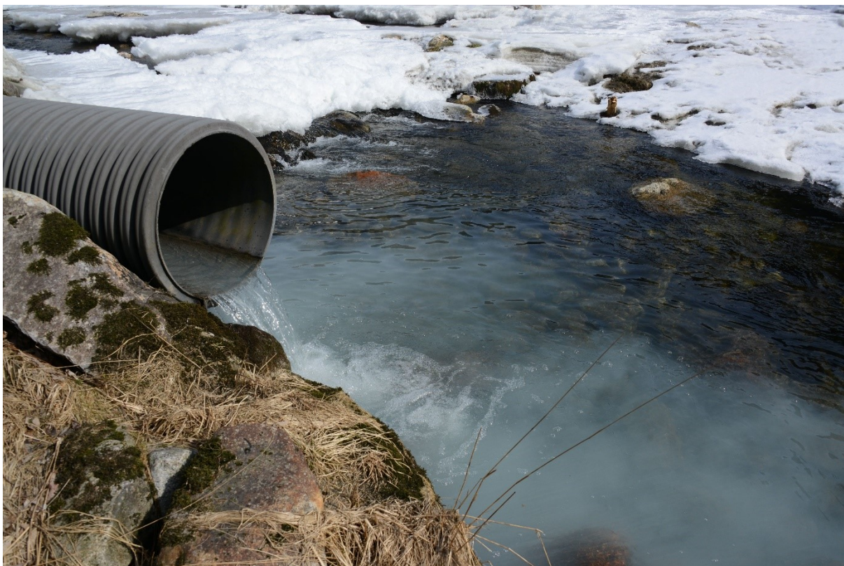
Bilete 10. Avløpsrør for overvatn med utslepp av diffus kloakk. Foto: Sveinung Klyve.
