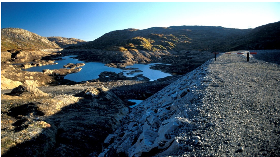
Bilete 3. Askjelldalsdammen i Eksingedalen er regulert 55 m med overføring til Evanger kraftverk i 30 km tunnel til anna vassdrag. Biletet viser dammen nesten heilt nedtappa i 1997. Slike prosjekt gjev store naturinngrep med sterkt endring i vassføringa, og vert kalla sterkt modifiserte vassførekomstar (SMVF). Foto: Sveinung Klyve.
