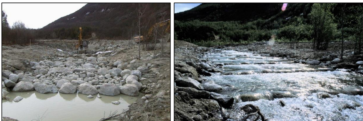
Illustrasjonsbilder. Det ble i åpningen av nedre sideløp anlagt flere cellederskler. Foto: Knut Aune Hoseth (NVE) 2001/2002.
