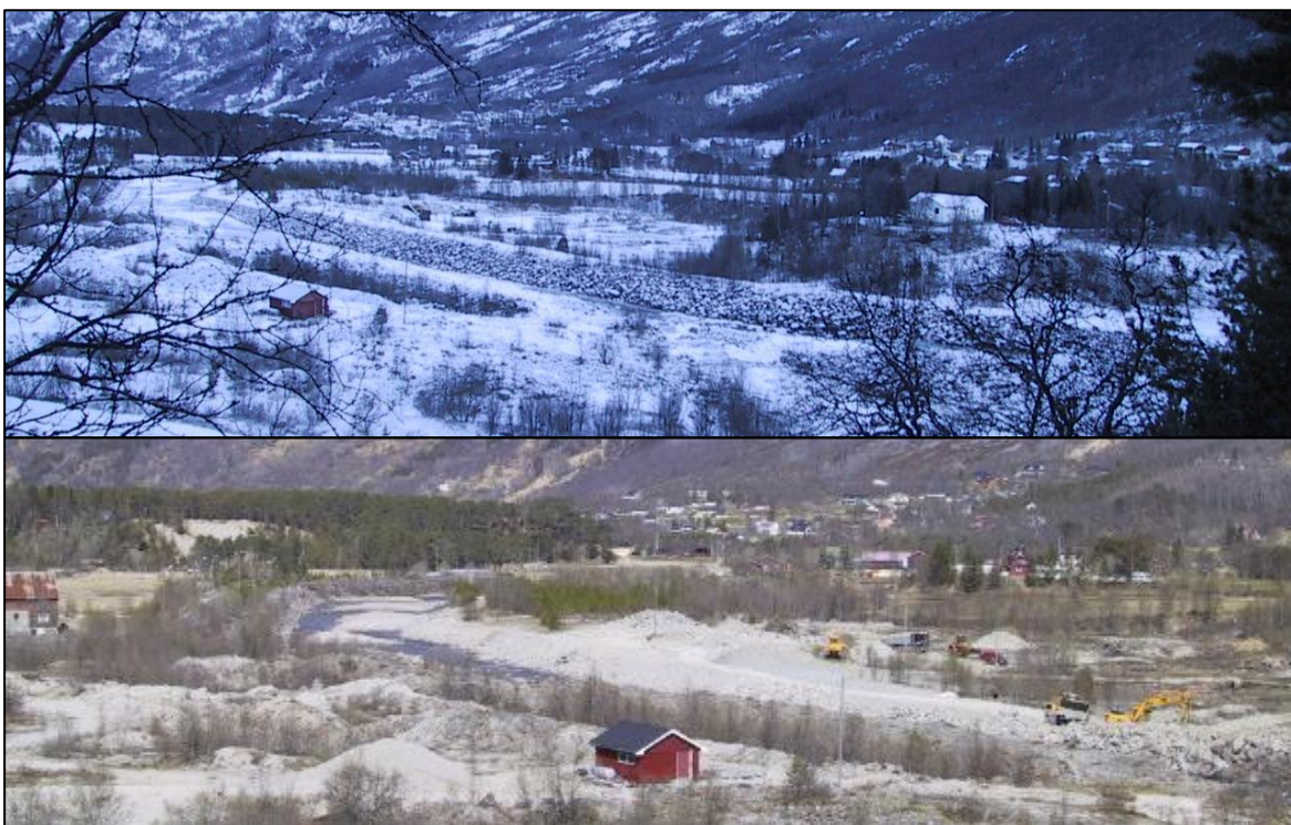
Illustrasjonsbilder. Sikringsanlegg før og under fjerning. Området bak anlegget er det nedre sideløpet som ble åpnet, og har i dag kontinuerlig gjennomstrømning. Foto: Knut Aune Hoseth (NVE) 2001.
