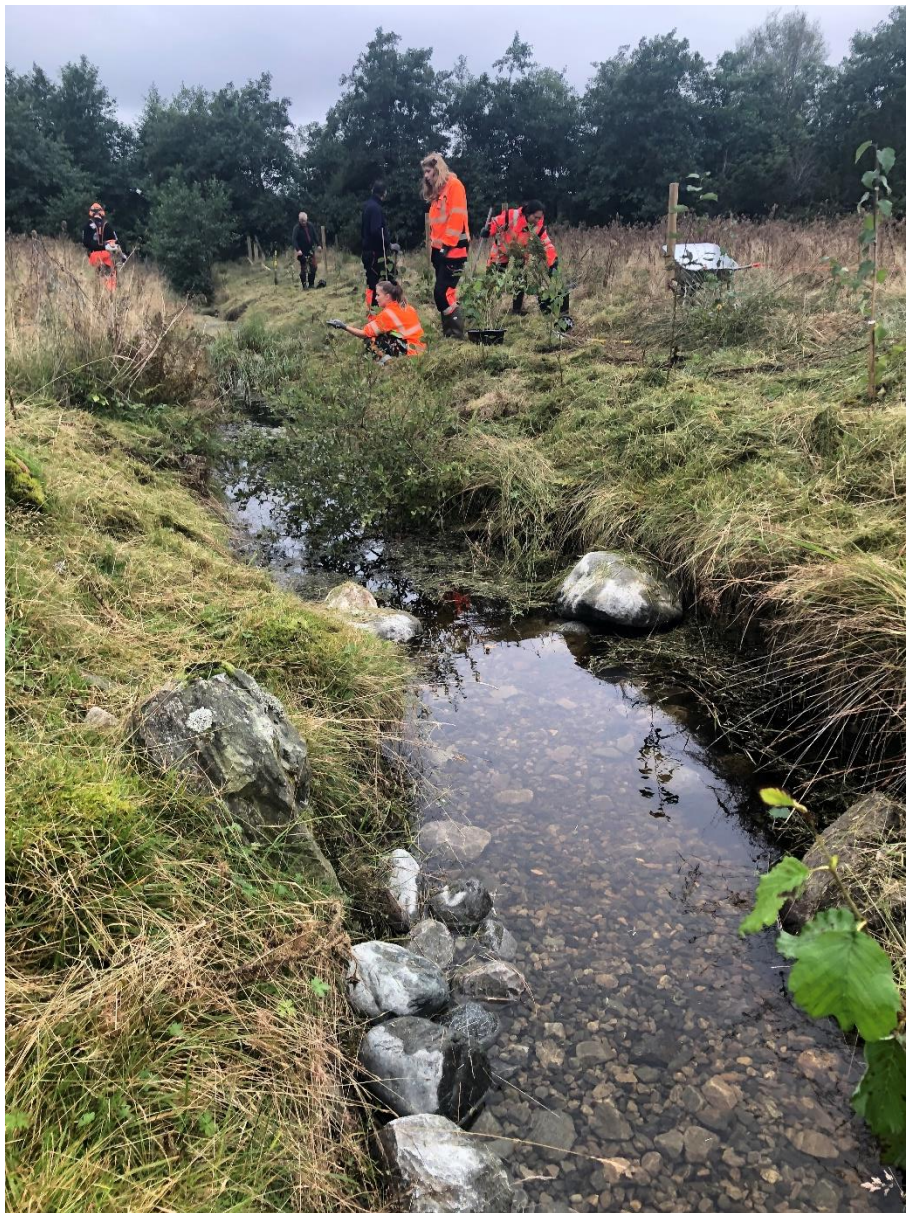
Illustrasjonsbilde. Ferdig utlagt gytegrus, og oppsetting av gjerde og planting av kantvegetasjon i segment 16 i Stangelandsåna.
