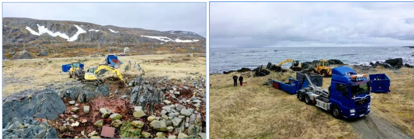
Fig 6.3: Opprydning i fra avfallsfyllingen ved Vargvikholmen i Berlevåg i juni 2019. Med dette tiltaket ble det fjernet 25,16 tonn blandede metaller, 18,64 tonn restavfall og 9,98 tonn betong m/armering.
