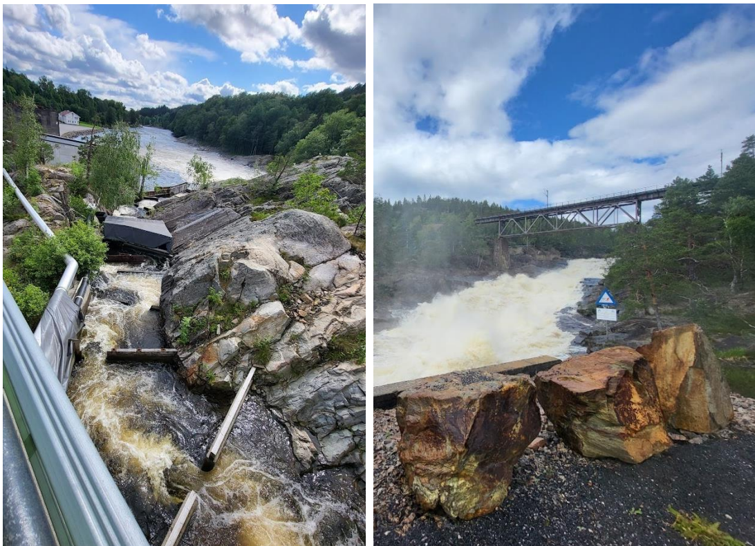
Figur 13 viser fisketrappa ved Boen kraftverk som tilrettelegger for oppvandrende laksefisk (t.v). Bilde til høyre viser Hanefossen, som er overløpselv fra Hanefossmagasinet, tatt etter nedbørsperiode. Normalt går fossen tørr.
