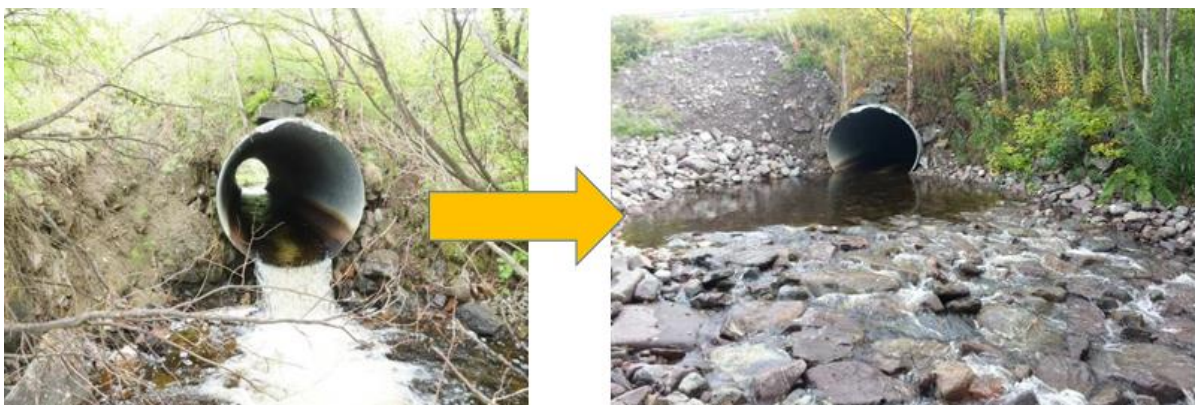
Figur 7: Bildet viser eksempel på restaurering av et menneskeskapt vandringshinder. Etter utbedring er det høye vannfallet fjernet, samtidig som det er etablert en kulp i utløpet av kulverten. Fisk kan passere det menneskepate hinderet og vannforekomsten oppnår god økologisk tilstand.
