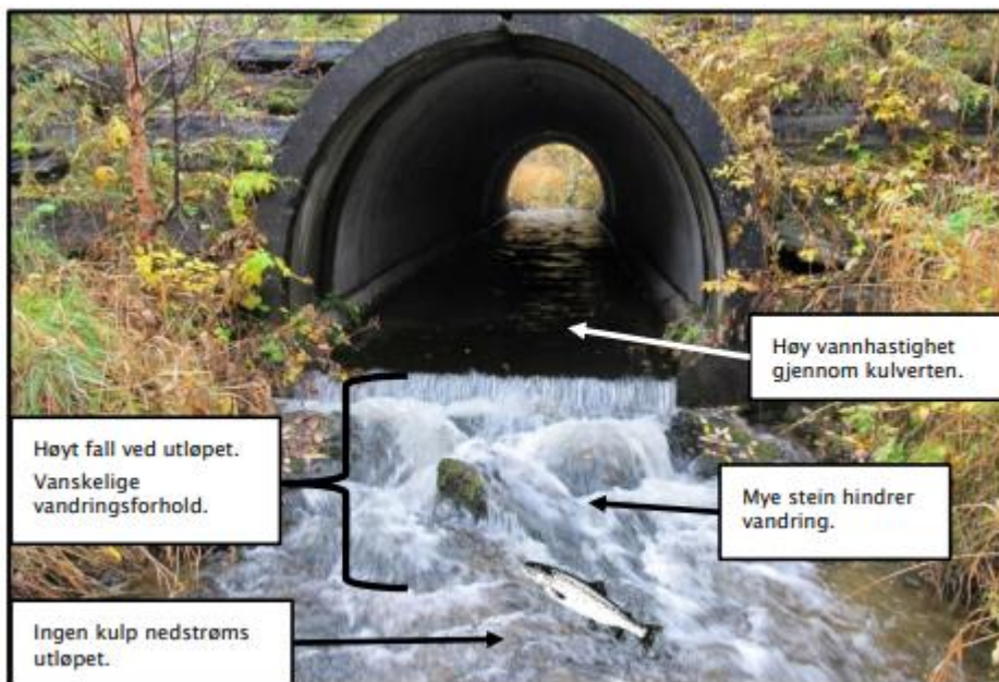
Figur 6: Illustrasjon av hvordan et vandringshinder under veg kan forhindre eller vanskeliggjøre fiskevandring.
