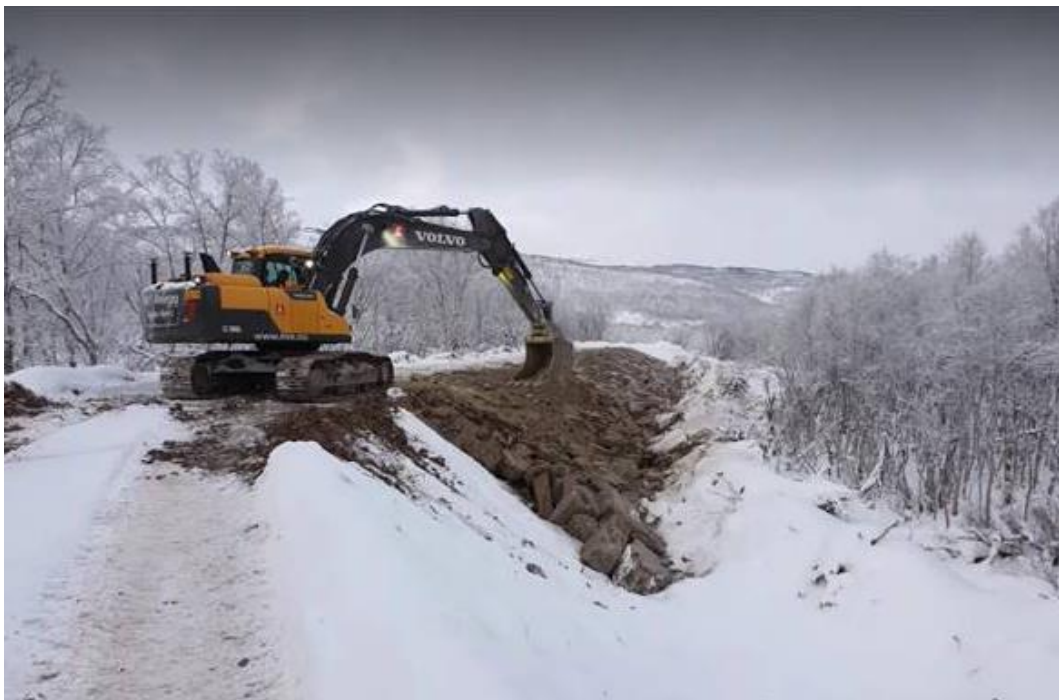
Figur 5: I perioden 1950 og fram mot 1980-årene ble det gjennomført mange store flom- og erosjonssikringsanlegg langs Juovlajohka/Julelva. Det medførte at hastigheten på vannet steg og oppvekst- og gyteområder for sjørøye ble redusert. På bildet ser vi at det etableres en erosjonssikring lenger unna dagens elveløp. Det vil gjør at elva får et større areal slik at vannhastigheten senkes og oppvekst- og gyteområder for sjørøye restaureres.
