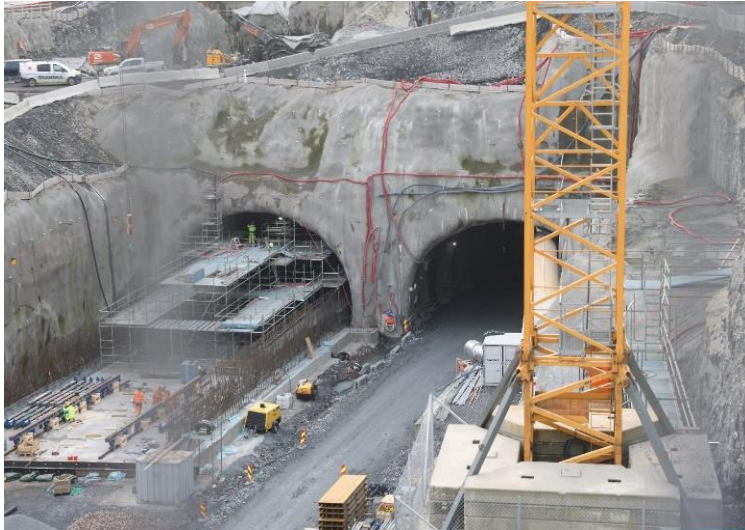
Figur 15: Byggegrøp ifm bygging av ny E18 ved Strand i Bærum. Overvann og anleggsvann ledes til Oslofjorden.
