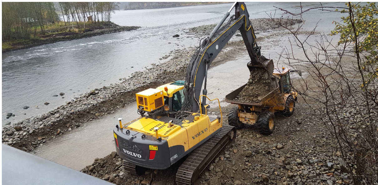
Bilete 12. Fjerning av flaummassar i store vassdrag kan vere viktig for å hindra skade. Her fjerning av massar under Evangerbrua i Vossovassdraget i 2020. Foto: Sveinung Klyve.
