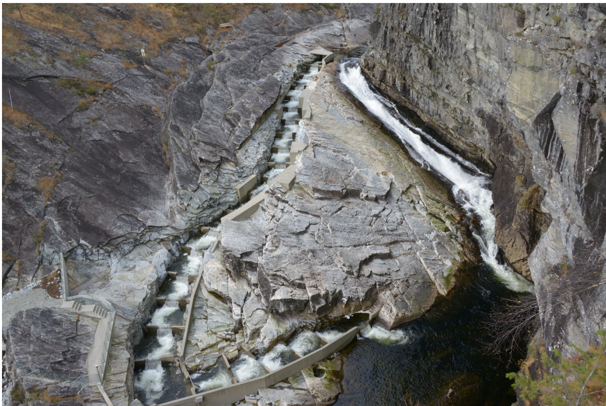
Bilete 5. BKK si laksetrapp frå 2010 i Raudfossen (fallhøgde 16 m) i Ekso gjer at laksen kan vandra opp til nye gyteområde i vassdraget. Foto: Sveinung Klyve.
