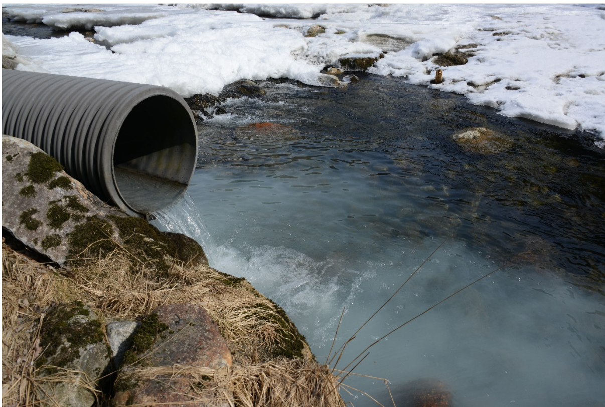
Bilete 11. Avløpsrør for overvatn med utslepp av diffus kloakk. Foto: Sveinung Klyve.
