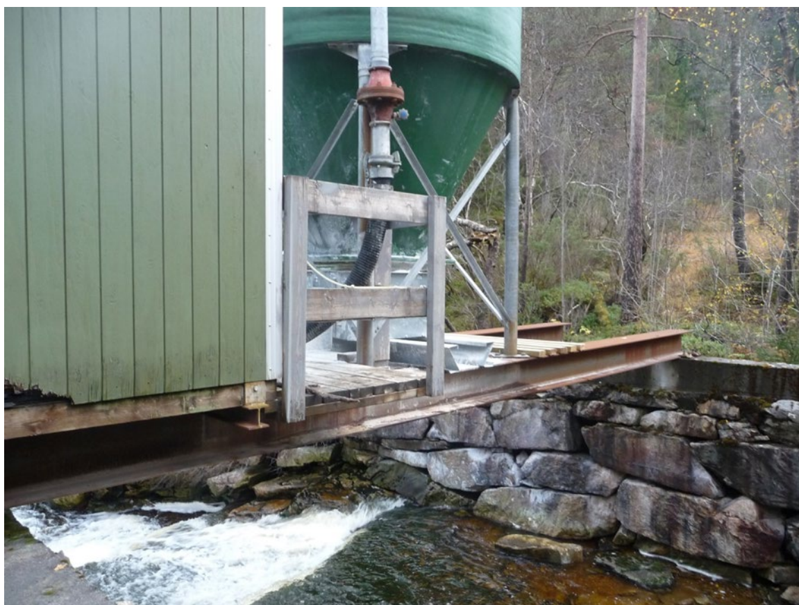
Bilete 9. Doseringsanlegg for kalk i Espedalselva i Fjaler. Foto: John A. Gladsø.
